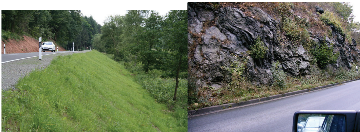
Πρανή επιχωμάτων H > 3\text{m} και ορυγμάτων με κλίση υ:β > 1:3 – Κατηγορία κινδύνου 4
